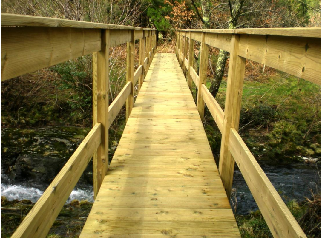
Construcción pasarela madera en Ambosores-Mañón, 2.008.
