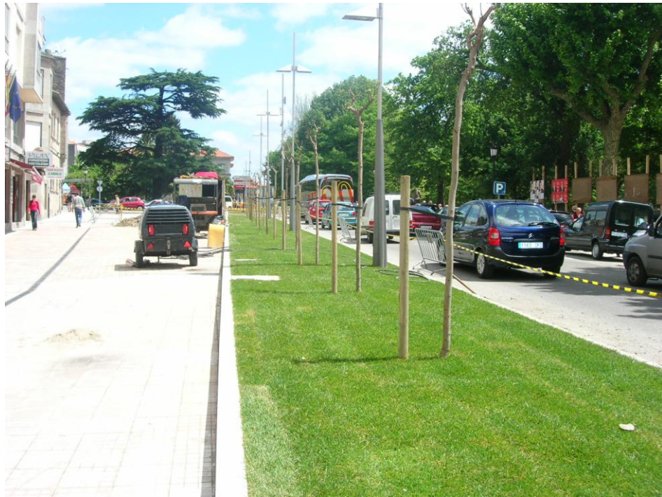
Plantación Jacarandás, tepe de césped y riego automatizado en mediana (junto alameda Pontevedra, 2.007)
