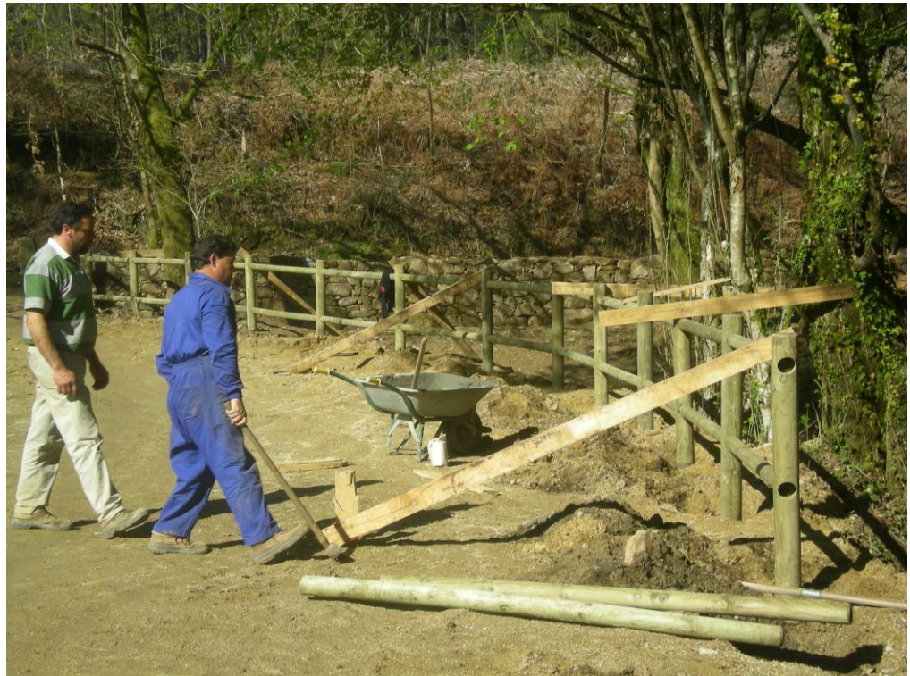
Construcción valla de madera, Santiago 2.011.
