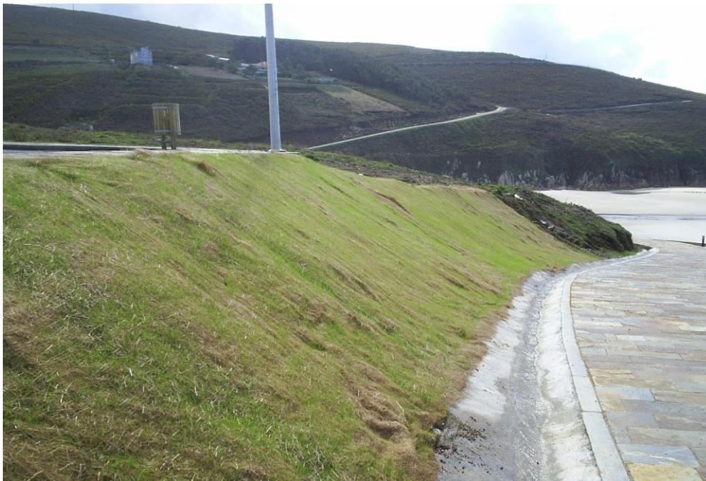
Hidrosiembra y colocación manta orgánica anti-erosión en Arteixo, 2.006.
