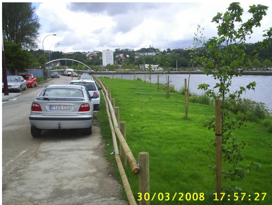
Césped al mes de realizada la hidrosiembra+plantación Liquidambar+valla madera tratada (Pontevedra ciudad, 2.007)
