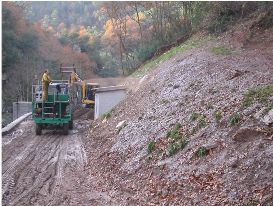
Aplicación hidrosiembra en talud A Lama-Pontevedra, 2.004.
