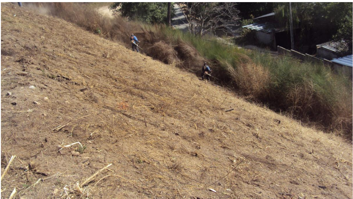
Desbroces manuales en taludes (Mos, 2.010)
