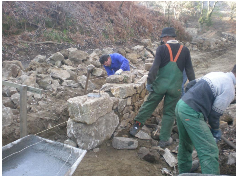
Construcción muros piedra, Santiago 2.011
