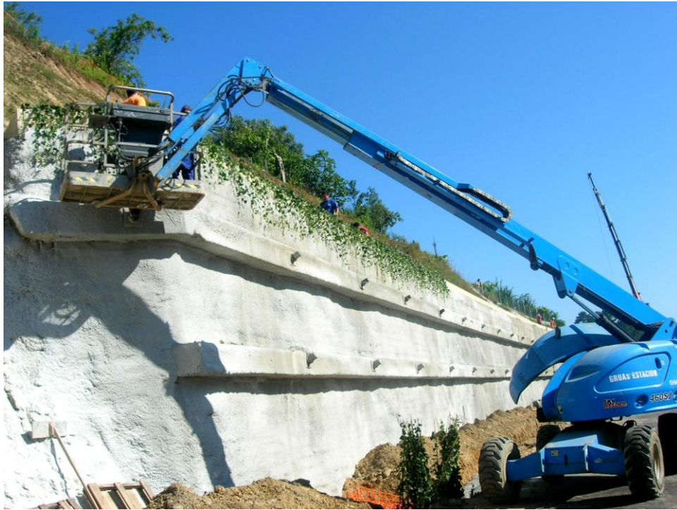
Apantallamiento muro autopista Santiago-A Estrada con yedras fijadas con cables, 2.007.
